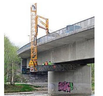
Die Brücke wurde mehrmals untersucht. FOTO: PRÖHL
